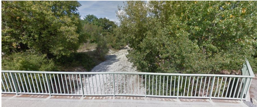
Figure 7: sur le Pont des tuilières en direction de l'amont
