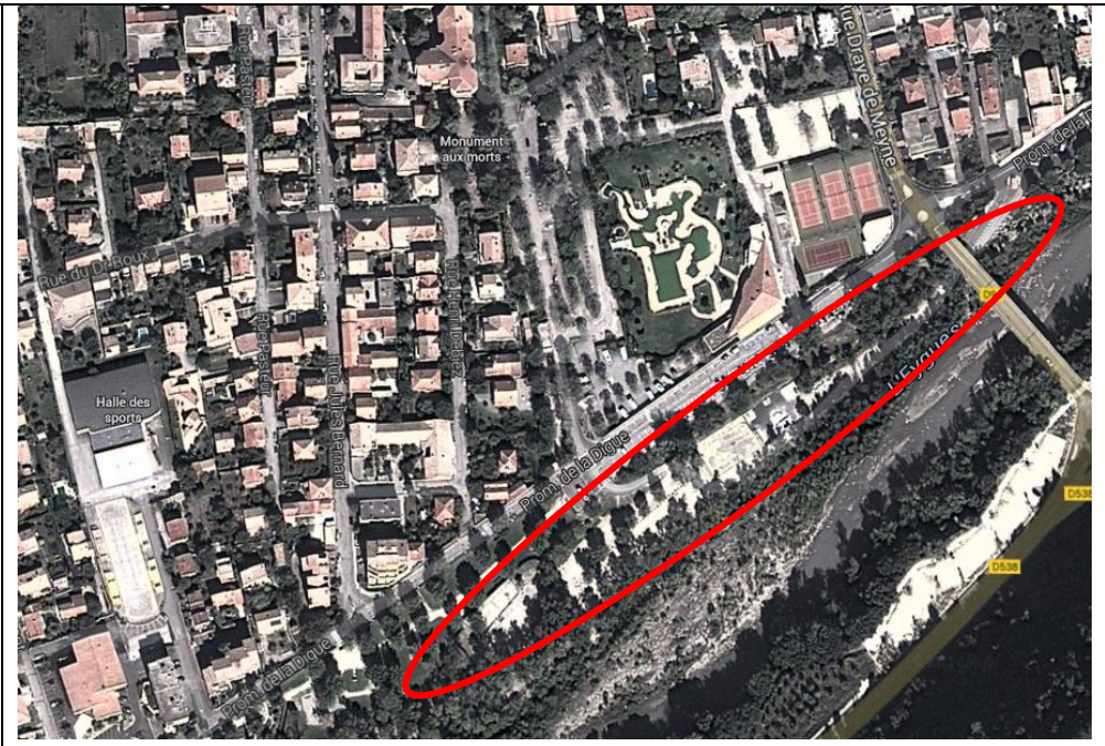
Figure 22: Localisation du parking de la digue
