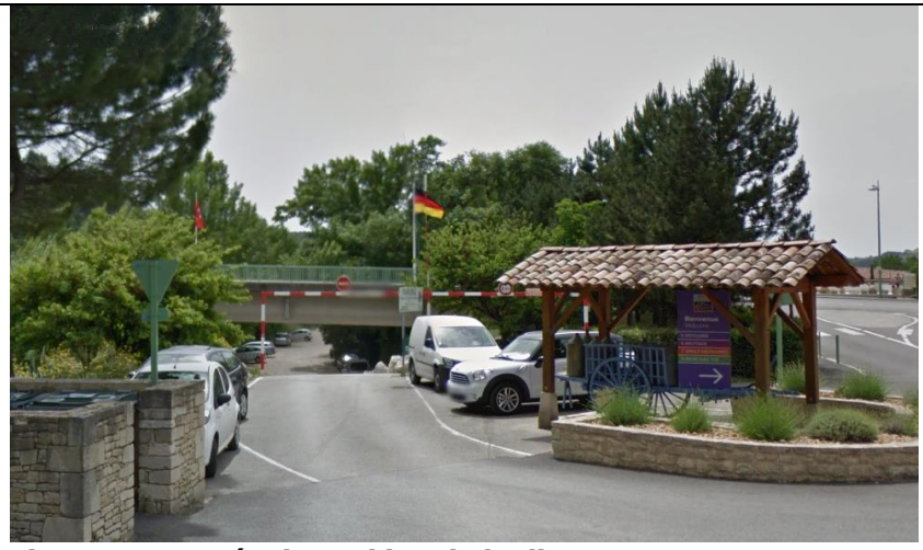
Figure 21: Entrée du parking de la digue
