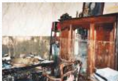
Dégâts matériels dans une habitation de Ste-Jalle, crue du 22 sept. 92. Photo X, collection Guy Teste, fonds Mémoire de la Drôme (29 MD TESTE 7)
