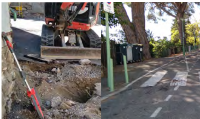
Travaux de la Montée des Petits Forts.
