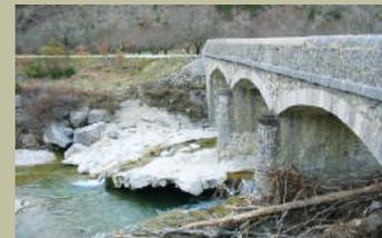
Embâcles sous une des arches constituées par des végétaux de grandes tailles et affouillement du seuil au pont de Cornillon. (Source photographique : SIDRESO)
