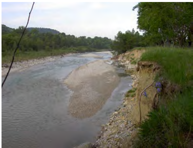
L'Eygues au droit de Nyons (érosions de berge en rive gauche)
