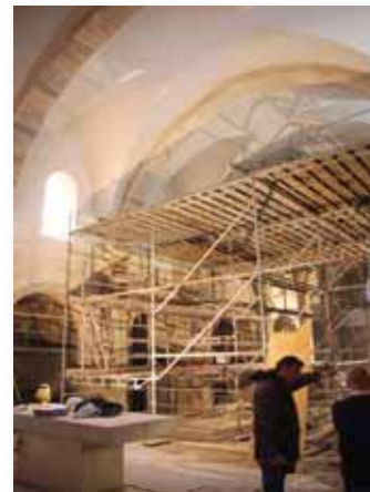
Echaffaudage pour réfection des voûtes de la nef
