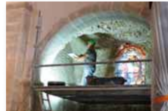
Réalisation des enduits dans une chapelle
